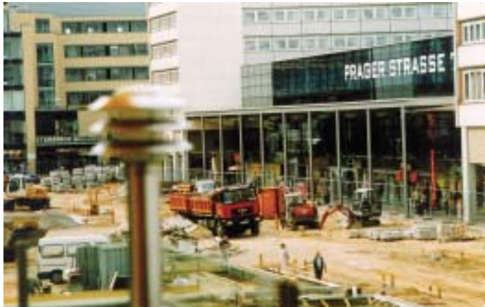
Es geht voran: Auf der Prager Straße in Dresden werden derzeit Flutschäden beseitigt. Gleichzeitig wird die beliebte Einkaufsmeile städtebaulich aufgewertet. Foto: Wauer
